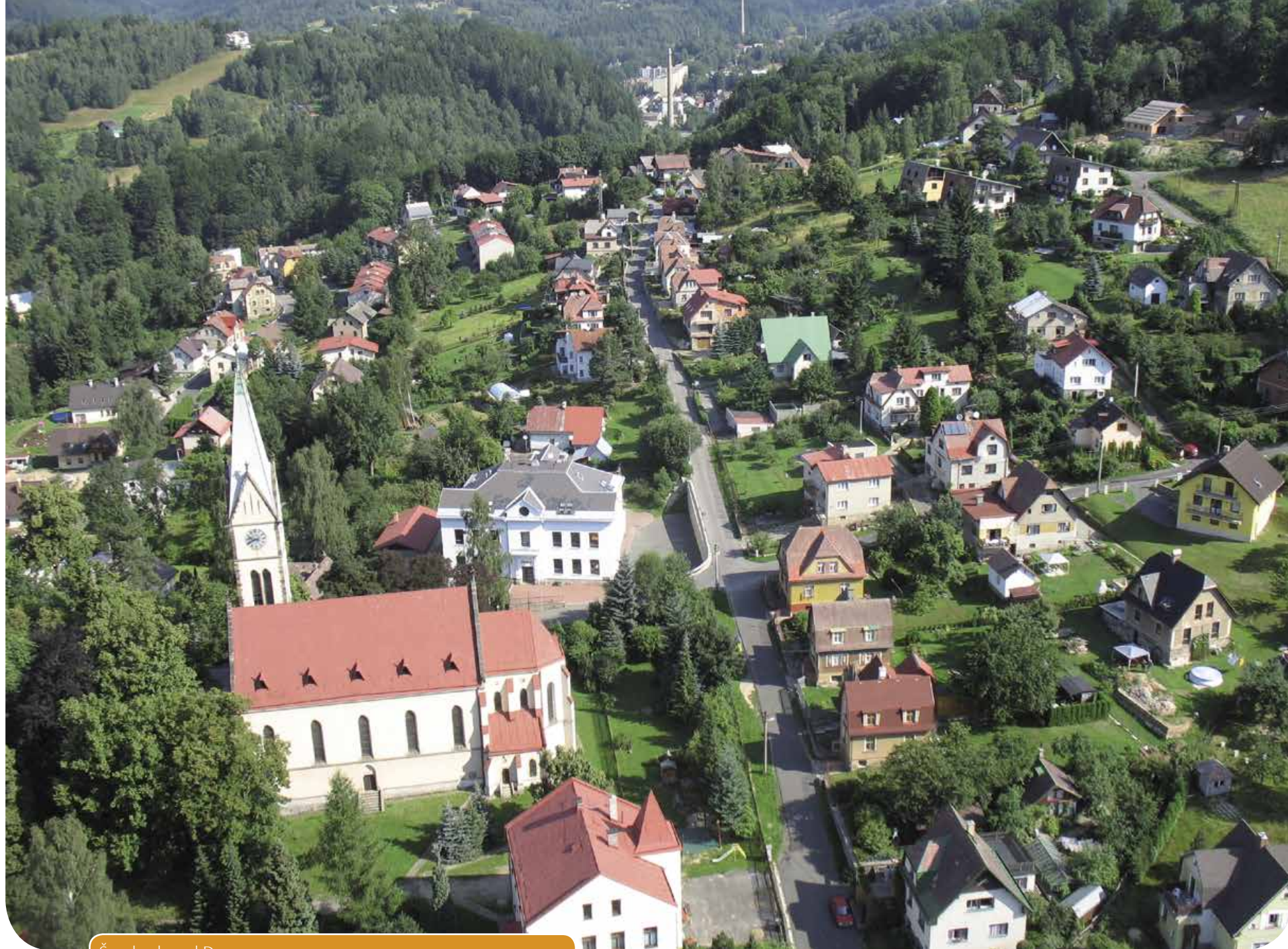
Šumbruk nad Desnou
