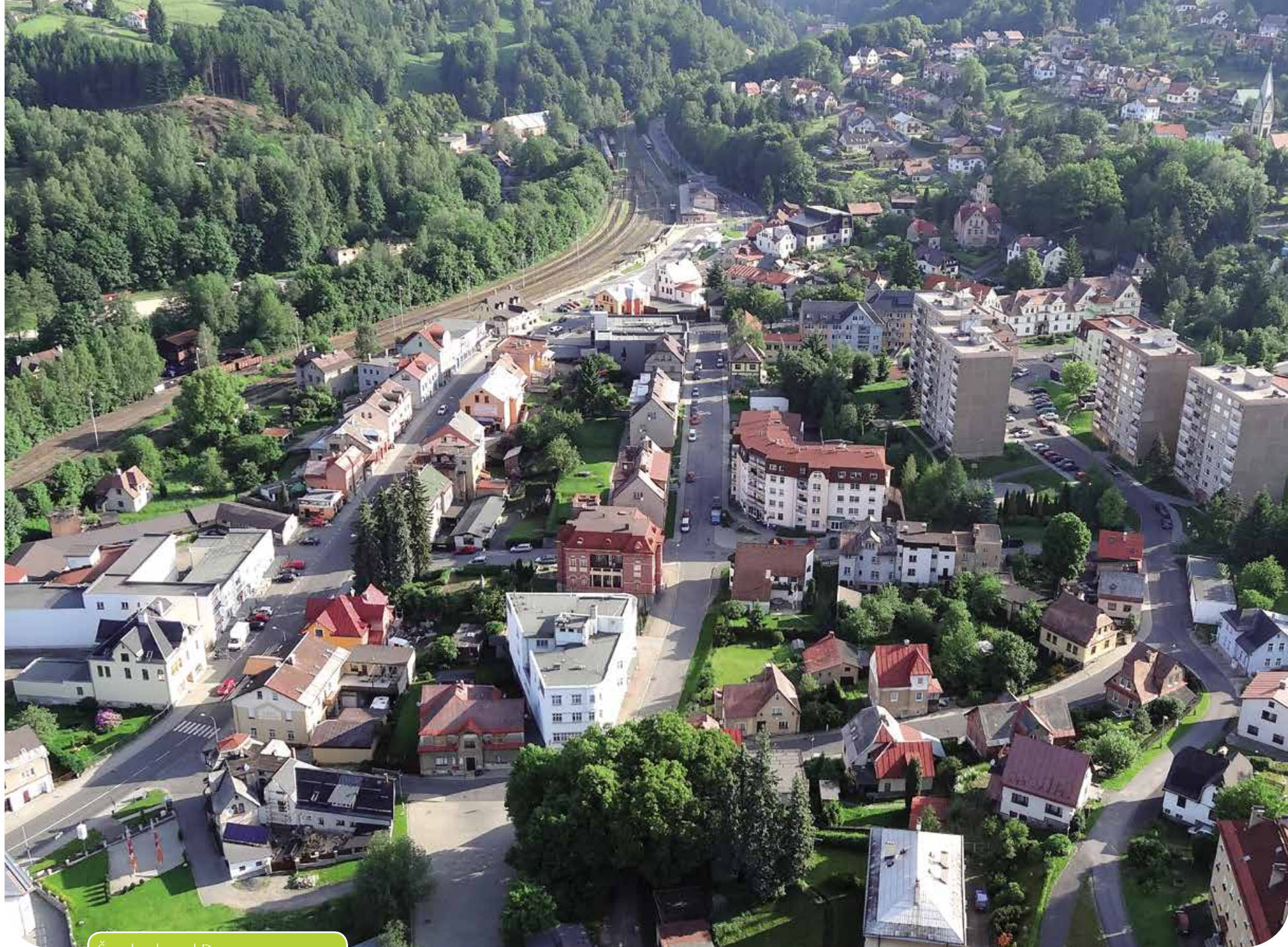
Šumbruk nad Desnou
