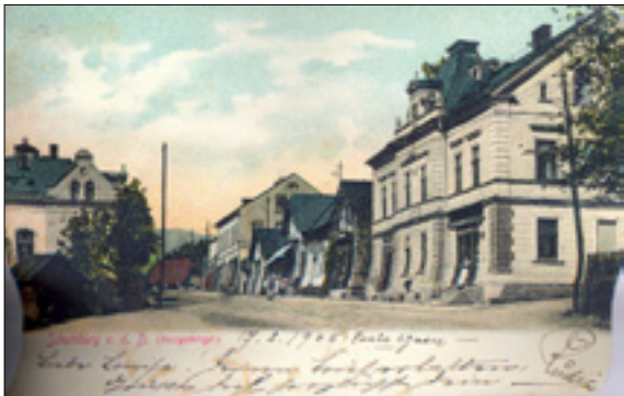
Říšská ulice v Šumburku n. D. okolo roku 1902. Stojící domy čp. 152, 117 a 188 se štítem do ulice, na levé straně snímku, byly po 1. světové válce odstraněny a na místě postaveny domy čp. 351 a 352, v proluce postavena hasičská zbrojnice a věž na sušení hadic.
