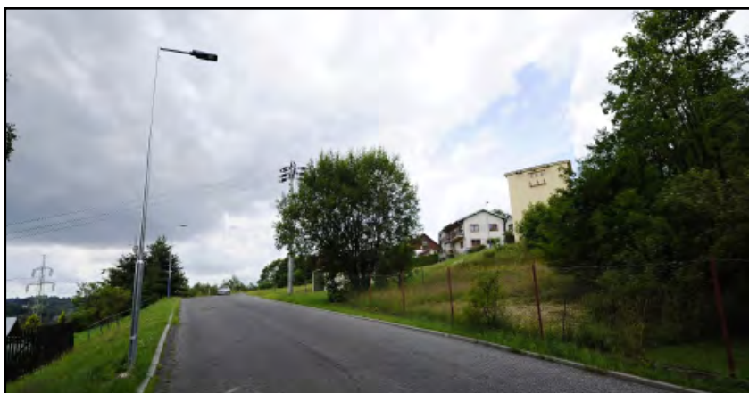
V Horské ulici byla provedena výměna starého osvětlení za nové, úspornější a s větší světelností. Foto Antonín Bělohožník.
