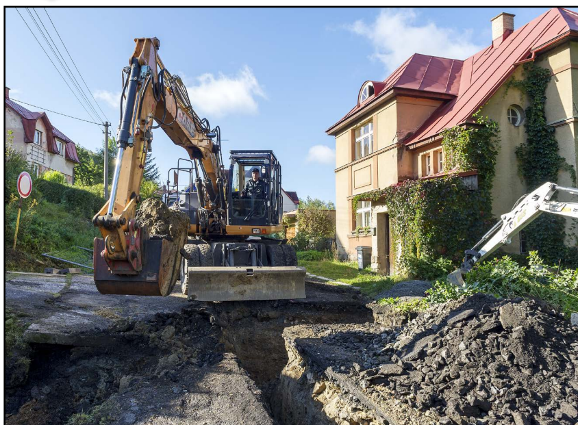
Úspěšně pokračuje 1. etapa stavby vodovodu a kanalizace ve Vitězná ulici. Stavbu v hodnotě 14 mil.Kč realizuje firma SIŽ, s.r.o. Velké Hamry.
