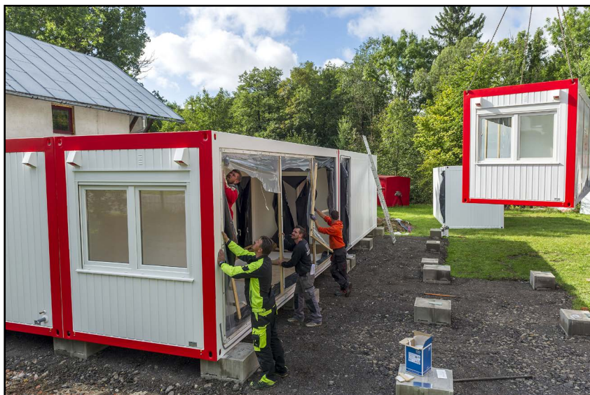
Koncem září došlo na Horním Tanvaldě v blízkosti bývalé hasičárny k instalaci nových obytných buněk, které se po napojení na potřebné sítě stanou novým zázemím pro činnost SDH Horní Tanvald.
