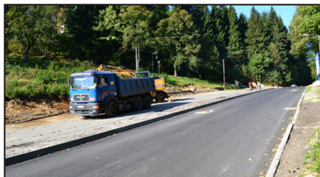
Postup silničních prací k 18. září.
