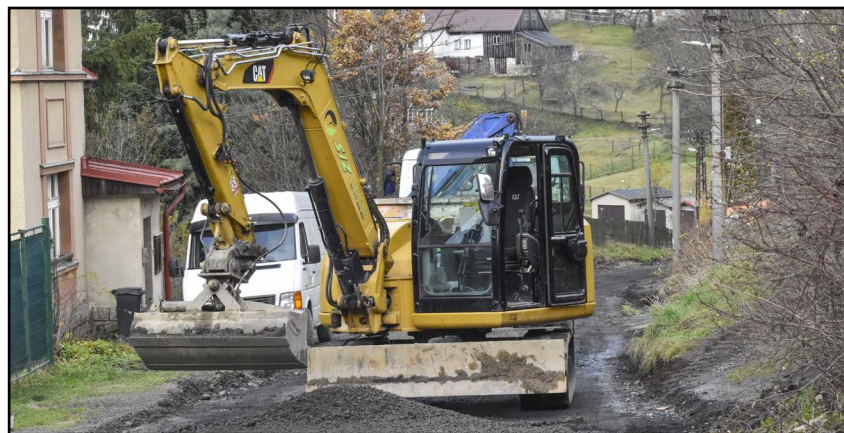
V době uzávěrky byly práce na kanalizaci ve Vítězné ulici v plném proudu.
