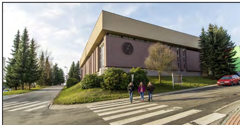
Během listopadu byla dokončena rekonstrukce městské haly na Výšině. Vedení města Tanvald se povedlo na rekonstrukci získat dotaci cca 8 mil. Kč ze Státního fondu životního prostředí. Hala byla kompletně zateplena, byla provedena výměna vzduchotechniky včetně osazení moderní klimatizací od jablonecké firmy Atrea, využívající rekuperaci tepla. Nový vzhled haly koresponduje s politikou vedení města, které postupně revitalizuje celé sídliště a zároveň se snaží, aby byly objekty v majetku města co nejúspornější. Foto Antonín Bělohožník.
