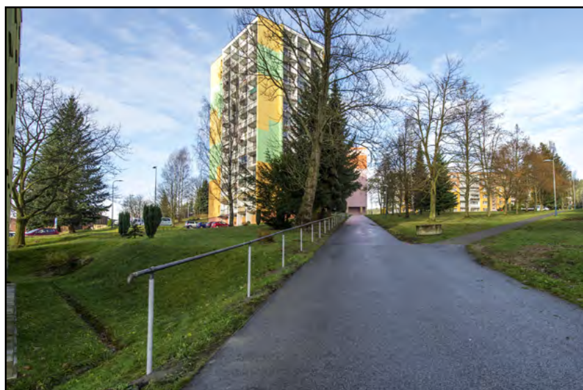
Na Výšině bylo vyměněno staré a zkorodované zábradlí za nové. Na jaře pak bude proveden nátěr a doplnění pochozího povrchu za nesmekající při námraze. Foto Antonín Bělohožník.
