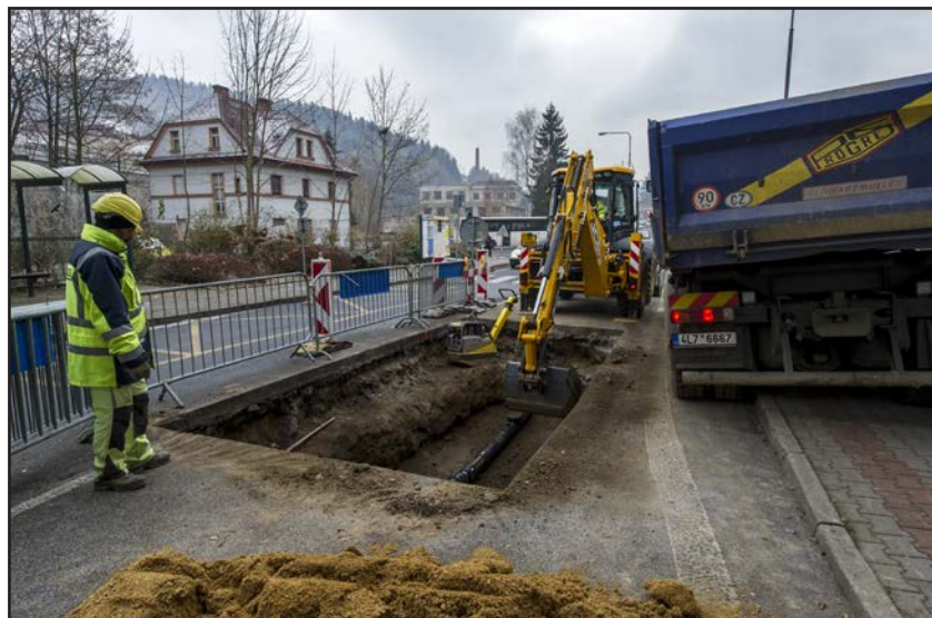
Začátkem listopadu byl omezen provoz na křižovatce ulic Nemocniční a Česká kvůli odstraňování havárie úniku plynu. Jelikož se závada nedala opravit obvyklým způsobem, ale speciální technologií, byla průjezdnost na silnici upravena semaforem. Stavbu prováděla firma Progres Liberec s.r.o. pro distributora plynu a nebyla to investiční akce města Tanvald. Foto Antonín Bělohožník.
