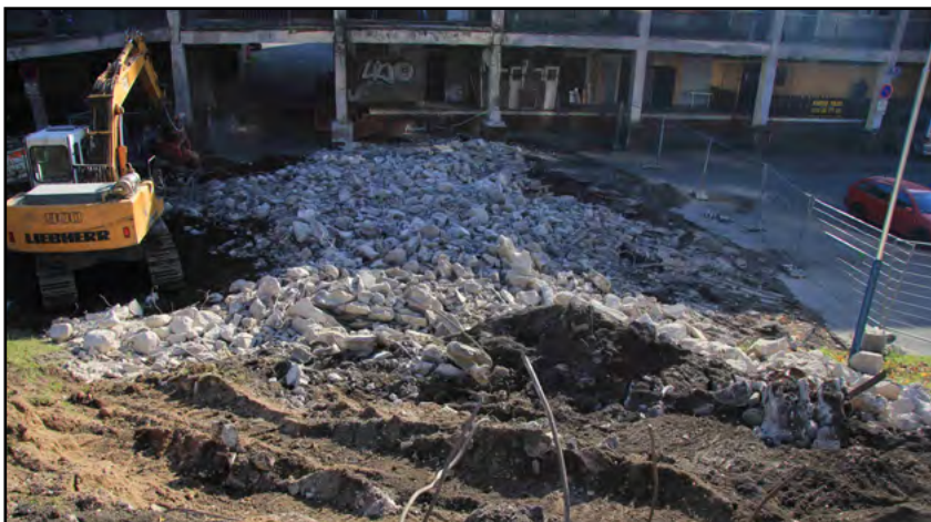
Koncem října byla zbourána lávka u bývalého nákupního střediska Výšina, ul. Horská. Foto Lubomír Soukup.
