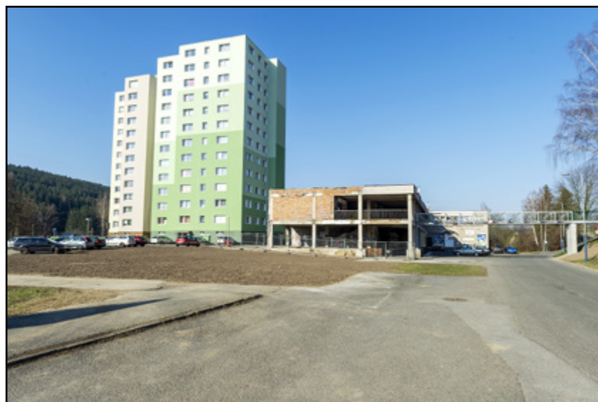
Úpravy u zbourané části bývalého nákupního střediska na Výšině
