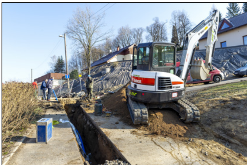
Vodovod na Šumburku
