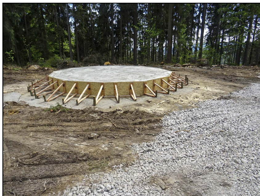
Práce na vyhlídce na Malém Špičáku jsou v plném proudu
