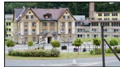
Neutěšený stav Turnhalle na autobusové zastávce.
