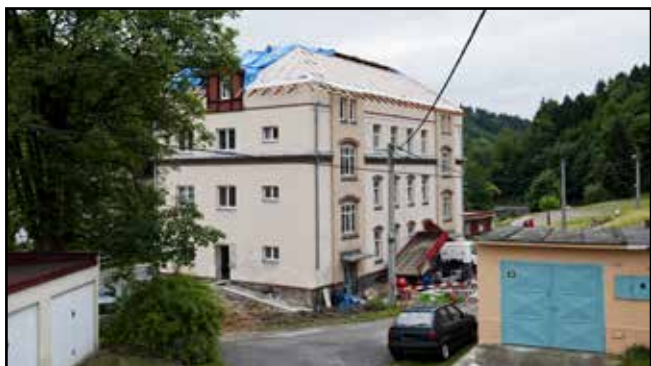
Na Četnickém domě jsou vidět probíhající opravy.
