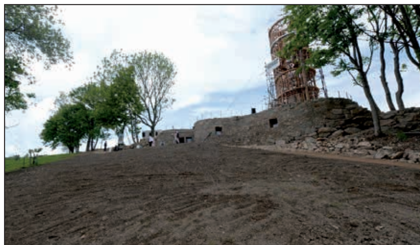
Základy Majáku Járy Cimrmana v Přířovicích. (foto: A. Bělonožník)
