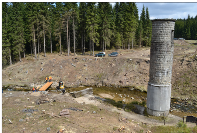
Prostranství přehradu po odlesnění. Na levé straně je vidět instalaci nové lávky přes vodu.
