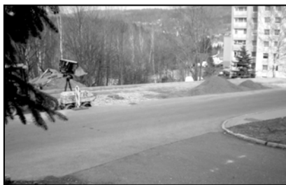
Staveniště je již v plném proudu.
