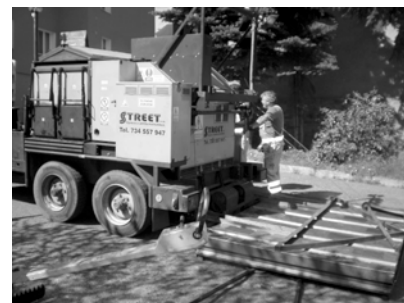
Obr. 1 - Sklopné čelo nahřeje místo výtluhu na 150 – 160 stupňů.
