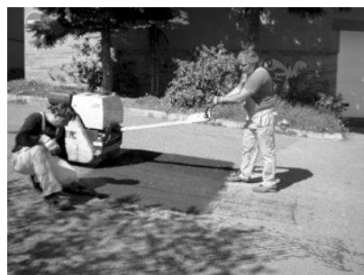
Obr. 3 - Důkladné uválcování je nezbytné pro kvalitu opravy.
