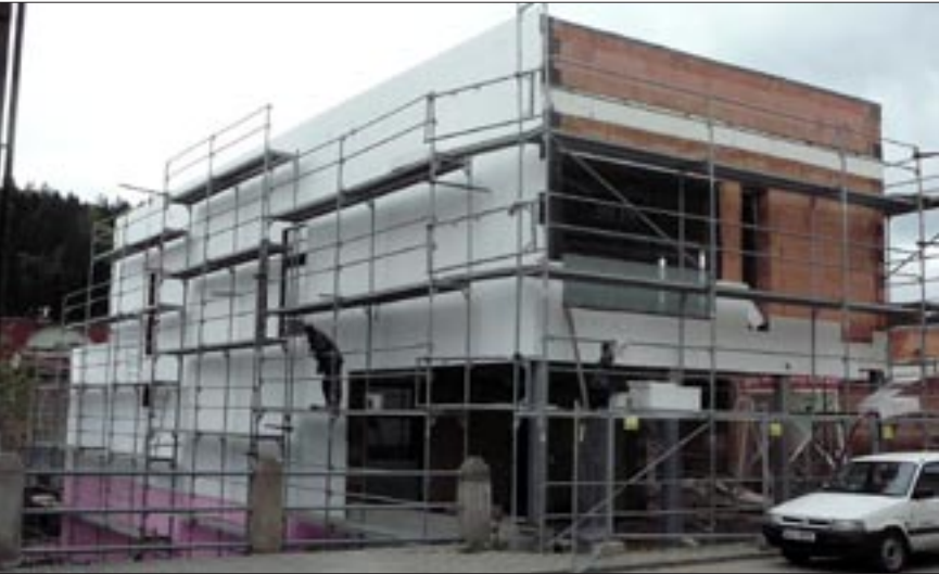
Hasičárna dostala teplý kabát. S pracemi na zateplení fasády hasičské zbrojnice SDH Tanvald Šumburk se začalo v půlce května. Hotové jsou vnitřní rozvody instalací, konkrétně vzduchotechnika, elektrorozvody, vodovodní, kanalizace i plyn. Koncem května začali zedníci pracovat také na vnitřních omítkách. Stavební práce podle slov vedoucího rozvoje MěÚ Tanvald Jiřího Onderky probíhají na obou stavbách kontinuálně. Termín dokončení hasičských zbrojnic je stanoven na 31. srpna 2010. Text a foto: M. Tůma
