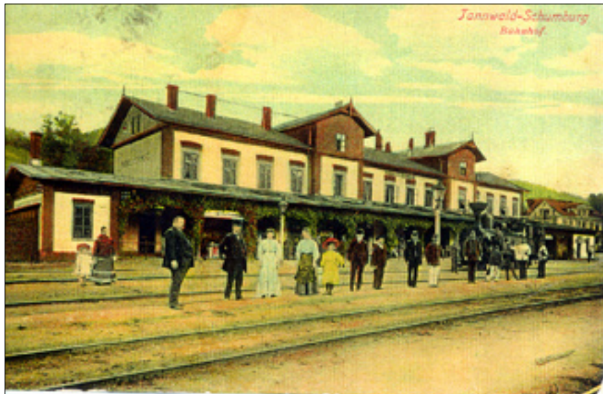
Železniční stanice, i když byla na katastru šumberském, měla od roku 1875 název Tanvald. Obecní zastupitelstvo Šumburk n. D. nebylo spokojeno a žádalo o změnu názvu. Tato změna byla povolena a od 1. května 1896 nese stanice úřední název Tanvald – Šumburk n. D. jako tehdy pošta.
