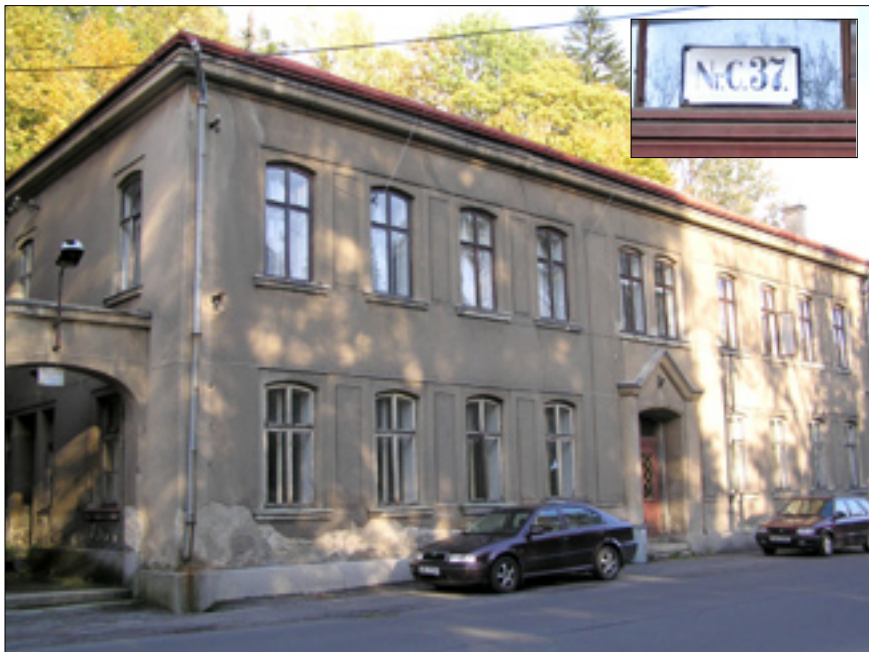
Na horním historickém snímku (z roku 1928) ze sbírky J. Rýdla je už přestavěný pivovar čp. 37 na Horním Tanvaldě na výrobní provoz pro firmu Johann Pribsch dědici a.s. Na levé straně objekt čp. 435, uprostřed čp. 37 a na pravé straně čp. 209. Spodní snímek zachycuje aktuální stav objektu, ve výřezu tabulka s původním číslem popisným.
